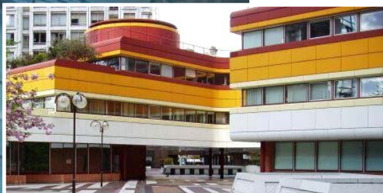
Obrázek 1 – budova Beaugrenelle – Paříž, Francie
